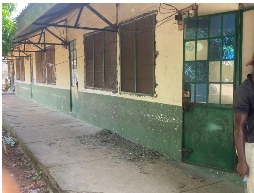
Te renoveren personeelsgebouw
